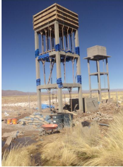
Nueva construcción de un tanque para agua potable en Llapallapani
