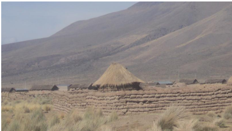
Tepes o ch'ampas utilizados en la construcción de Chhujllas (casa) y canchones
